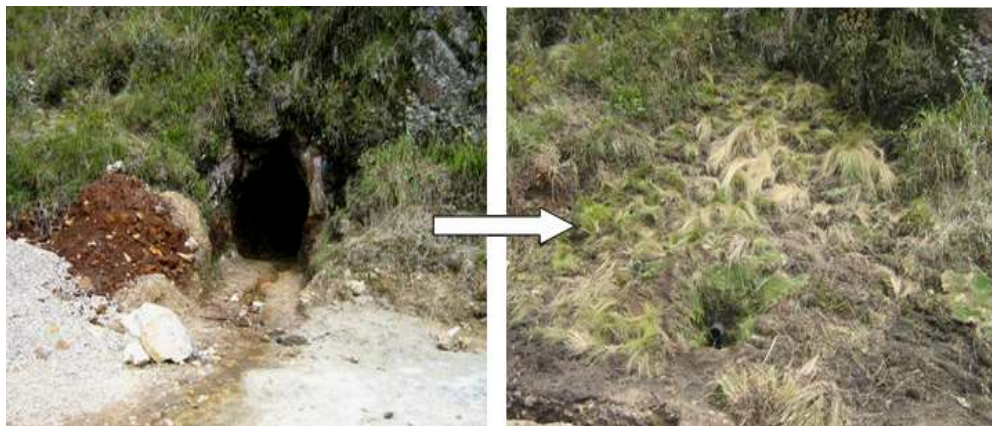
Fotografía N° 3: Bocamina antes y después, rellena y revegetada. Colquirrumi
