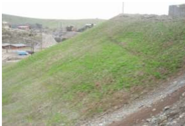
Fotografía N° 8: Cierre y revegetación del depósito de relaves. Colquijirca
