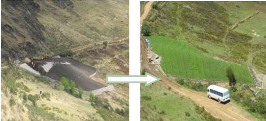
Fotografía N° 5: Cierre de depósito de desmonte
