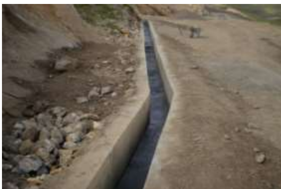
Fotografía N° 9: Canales de coronación
