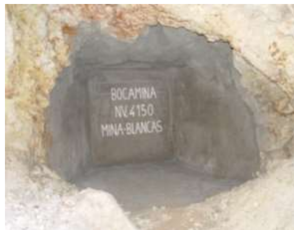
Fotografía N° 2: Cierre de bocamina sin drenaje, Julcani.
