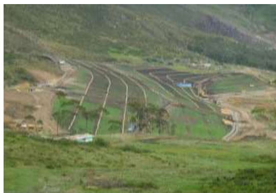
Fotografía N° 11: Gavión culminado, construcción de cuneta cancha revegetada. Colquirrumi
